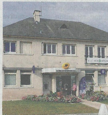
La Maison des services du Blaisois à Vineuil.
